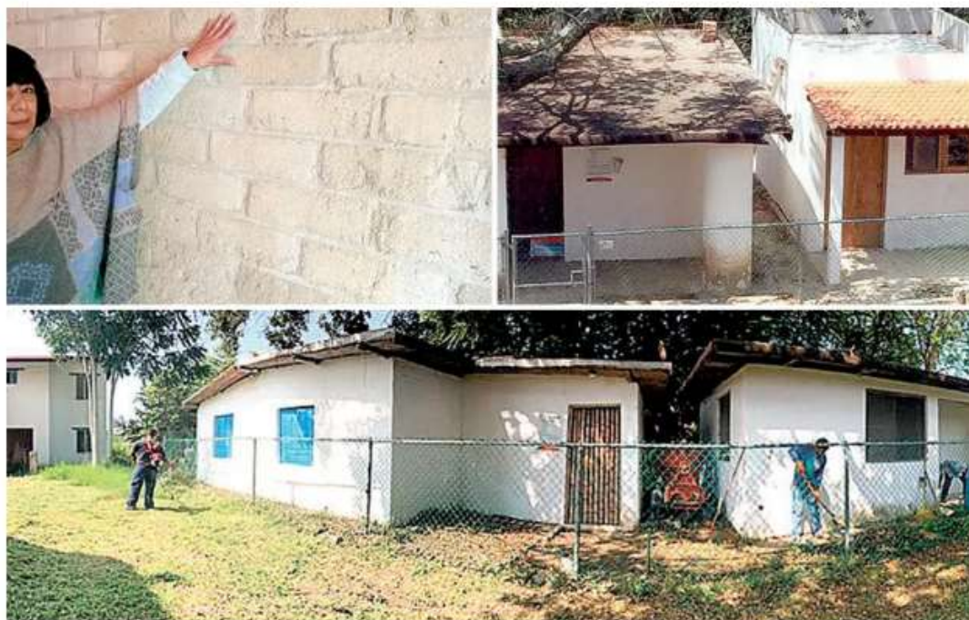
Construcción de casas con material ecológico, ideal en zona costera: UAT
